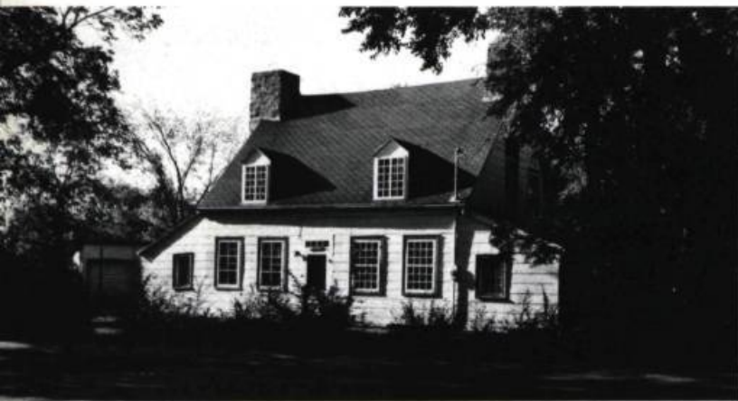
La maison Thomas-Whitehead, avant sa rénovation. Construite au début du XIX e siècle, elle possède des caractéristiques de l'architecture traditionnelle et de l'architecture palladienne. (photo: ministère des Affaires culturelles, Direction régionale de Montréal)
