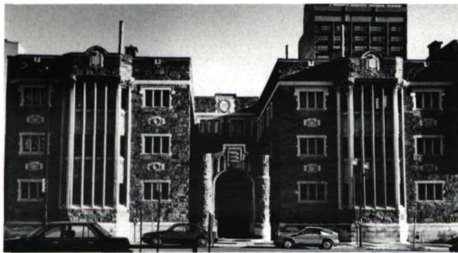
L'Ambassador Court, 2025-2061, boul. Décarie Année de construction: entre 1920 et 1930
