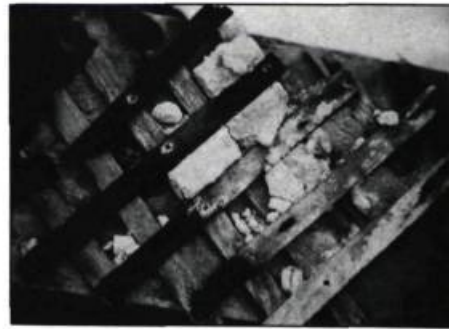
11. Vue rapprochée d'un recouvrement intérieur en lattes entrecroisées et clouées à la charpente. (photo: F. Varin)
