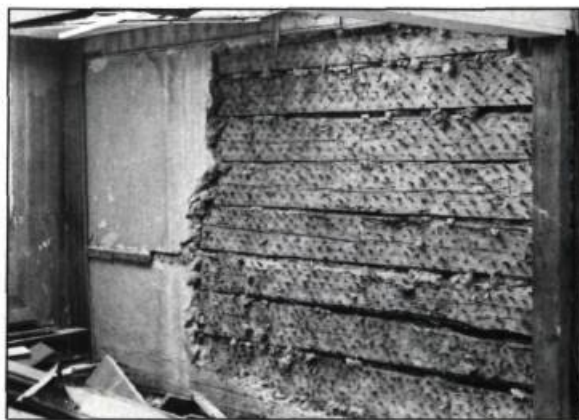
2. Illustration d'une très ancienne technique de recouvrement en plâtre d'un carré en pièces sur pièces. Ce rare vestige, découvert lors de la démolition d'une très vieille maison, montre les chevilles de bois incrustées dans les poutres pour faciliter l'accrochage des couches de plâtre. (photo: R. Bilodeau)
