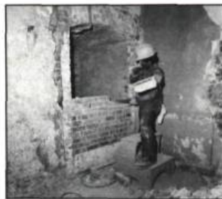
6. Ancienne ouverture murée au siècle dernier, découverte au moment du curetage. Des plans anciens nous en révélaient l'existence. (photo: Parcs Canada)
