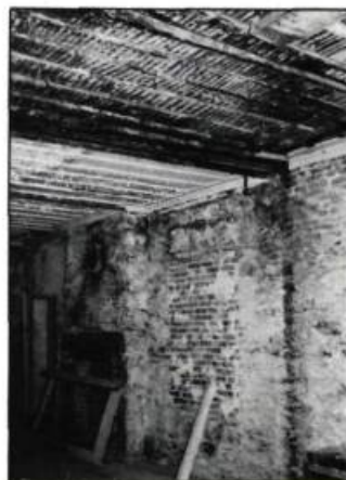
2. Illustration d'une très ancienne technique de recouvrement en plâtre d'un carré en pièces sur pièces. Ce rare vestige, découvert lors de la démolition d'une très vieille maison, montre les chevilles de bois incrustées dans les poutres pour faciliter l'accrochage des couches de plâtre. (photo: R. Bilodeau)
