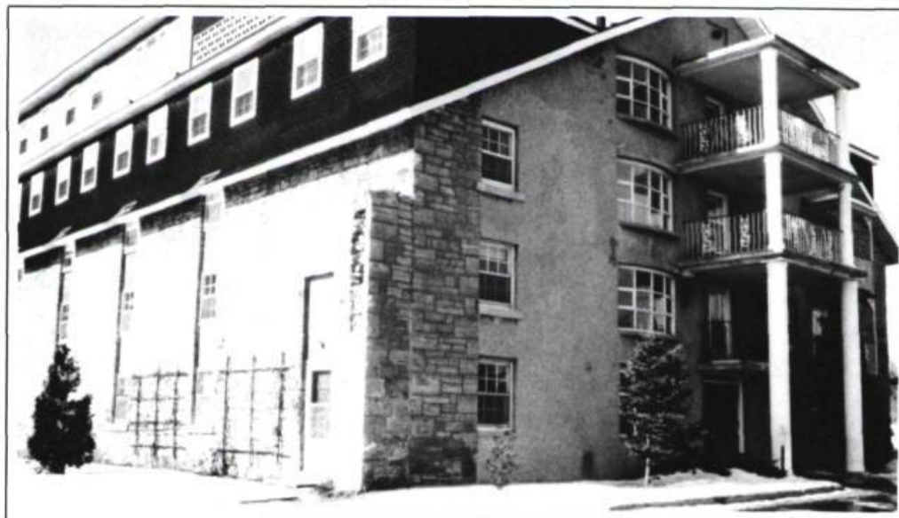
Le bâtiment reconverti en 1982.
