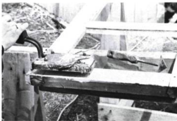
G L'utilisation du fer à élément chauffant simplifie et facilite le décapage lorsqu'il faut mettre le bois à nu avant de repeinturer.
