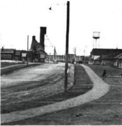
Vue d'ensemble du village minier en 1936 soit un an après la construction. À l'arrière plan le chevalement de la mine Lamaque.
